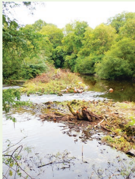
Vu sur l'ancien seuil de l'usine du Bô.
