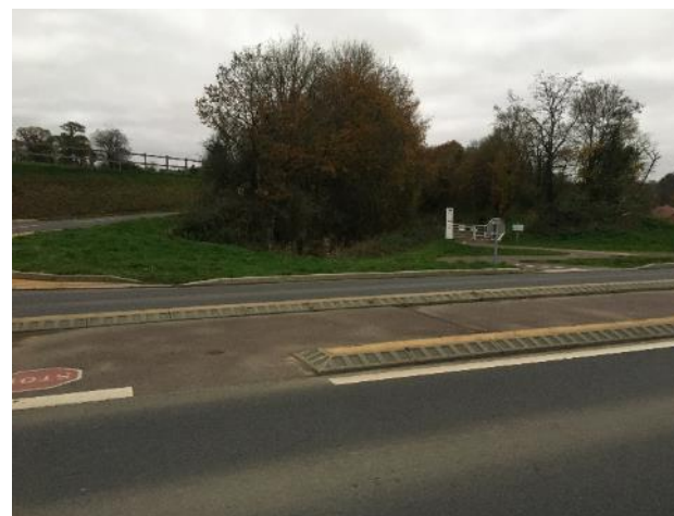
Entrée/sortie de la voie verte à Saint-Rémy
