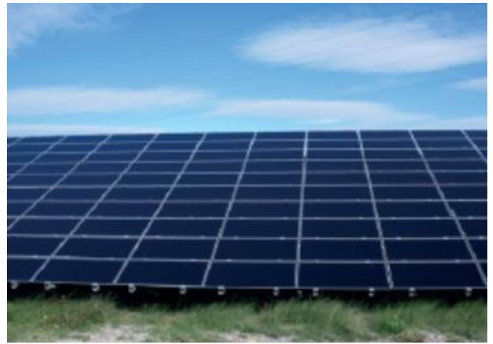
CENTRALE PHOVOLTAIQUE VUE DE FACE
