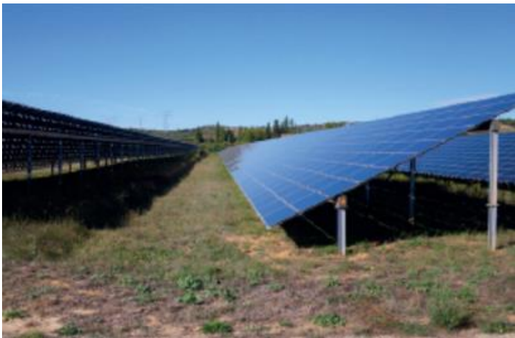
CENTRALE PHOVOLTAIQUE VUE DE PROFIL
