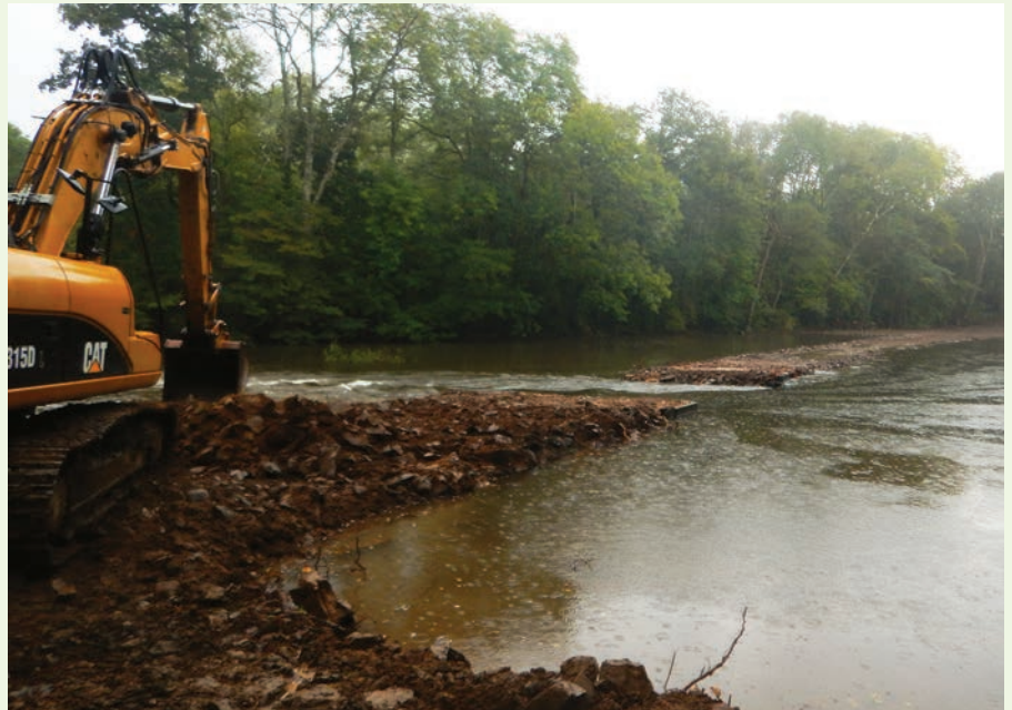
Abaissement de l'ancien seuil et maintien d'une veine d'eau
