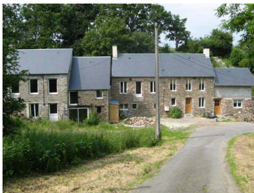
Rénovation et extension de constructions traditionnelles au hameau La Varende.
