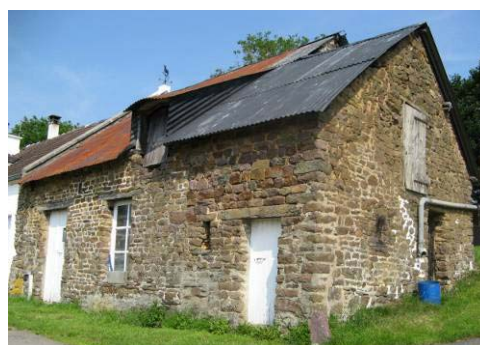
La maison de l'ouvrier agricole
