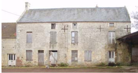
Ferme de Grainville (bâtiment dans la cour)
