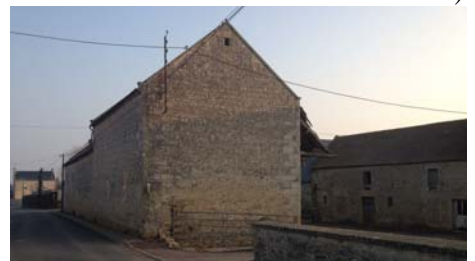
(bâtiment côté rue)
