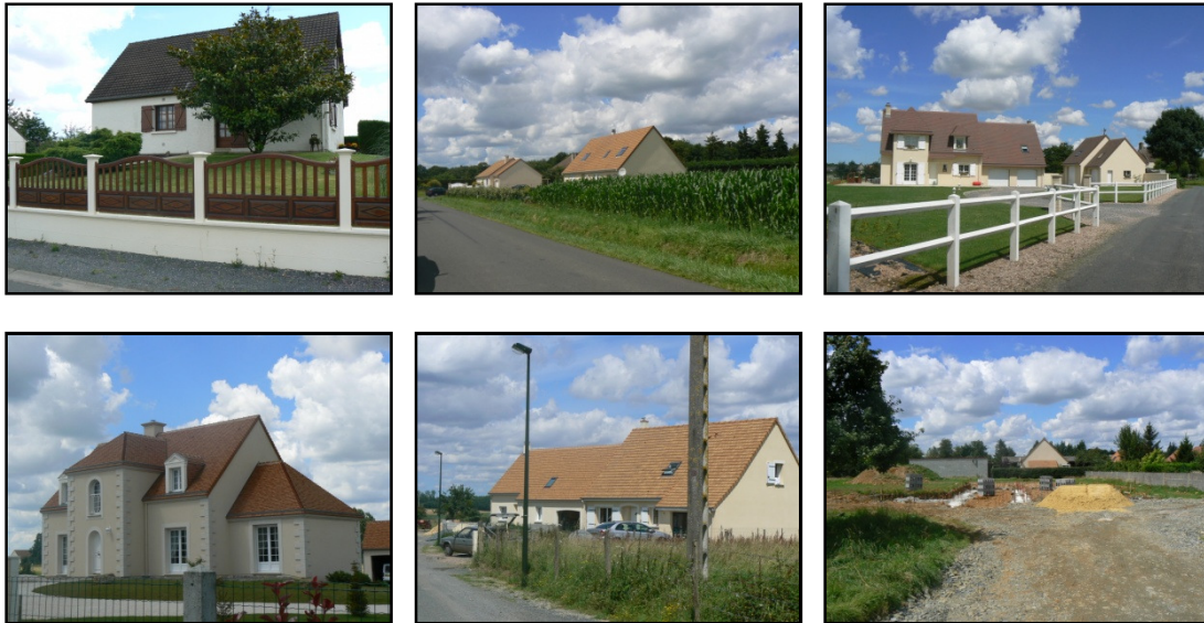
Photos n°45, 46, 47, 48, 49 et 50: Constructions récentes au sein du bourg
