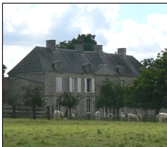
Photo n°55 : Le Manoir, à l'Est du Village (appelé aussi « Le Château »)
