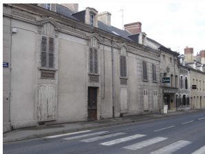
Lucarnes du bâti traditionnel
