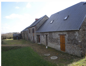
Toiture en ardoise du bâti traditionnel
