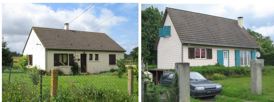
Les pavillons sont généralement implantés en milieu de parcelle paysagère au sein d'un tissu bâti existant. Les habitations sont souvent à deux niveaux : un Rez De Chaussée et un étage en combles aménagés. Les murs en parpaings sont recouverts d'un enduit de ton clair. Ils possèdent rarement un sous-sol.
