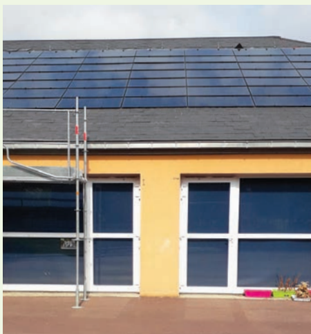
Pose de panneaux photovoltaïques à l'école de Barbery
