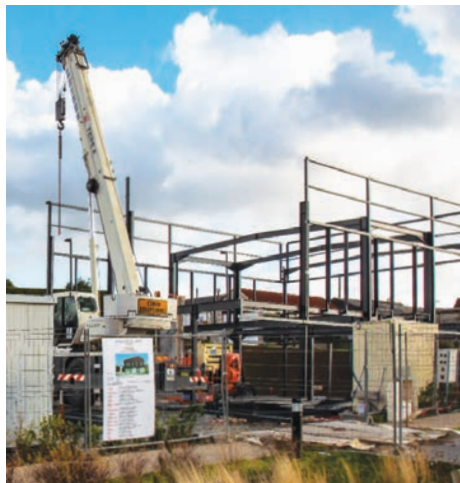
Travaux en cours de l'étude notariale
