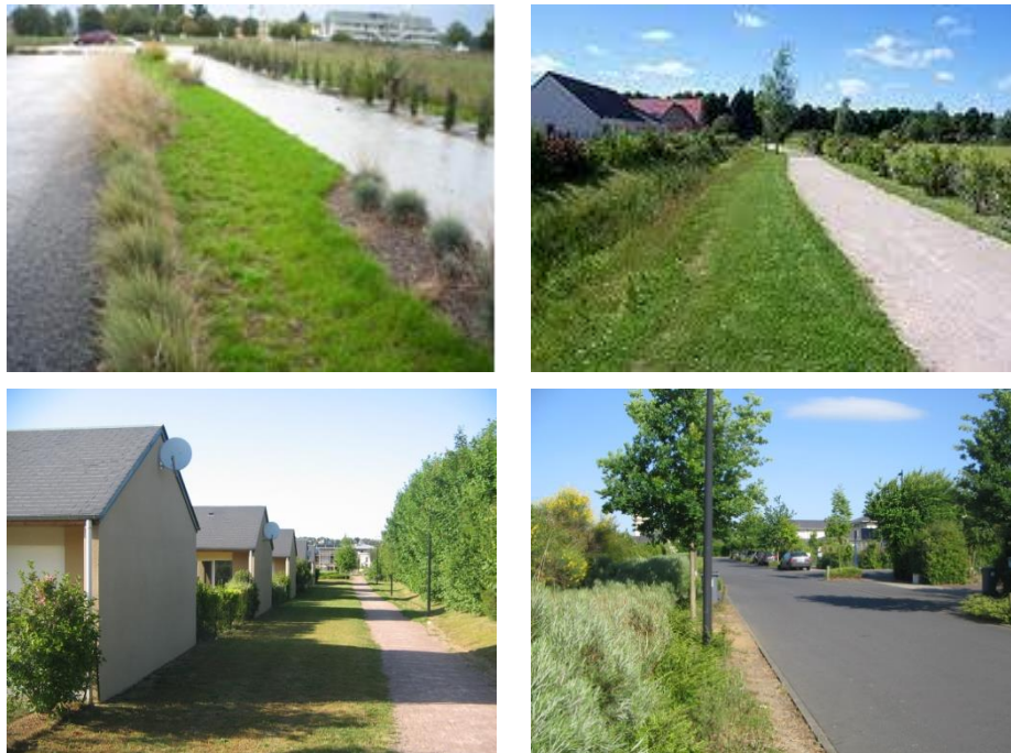
Exemples de noues paysagères et cheminements piétonniers
